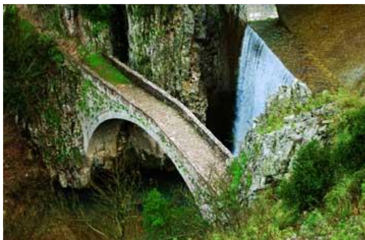
Πέτρινο τοξωτό γεφύρι, στον Ασπροπόταμο.
